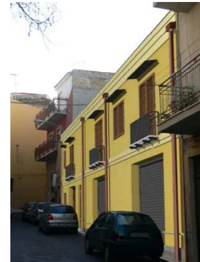
Vista da Via Quattrocchi verso via Gigante
