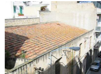
Vista dall'alto della copertura
